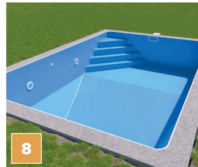
8 POSE DU LINER
