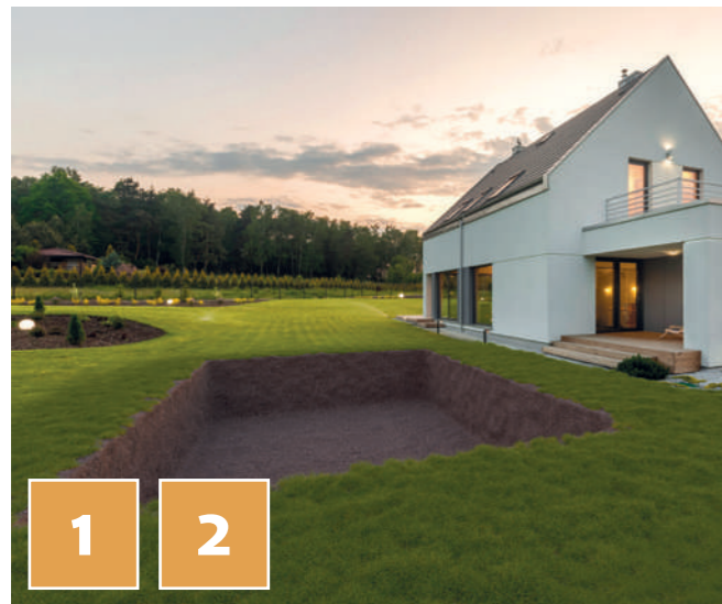
1 2 TERRASSEMENT ET CONTRÔLE DES NIVEAUX
