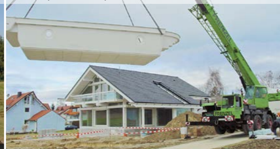
Installation à la main, par grue ou par hélicoptère.
