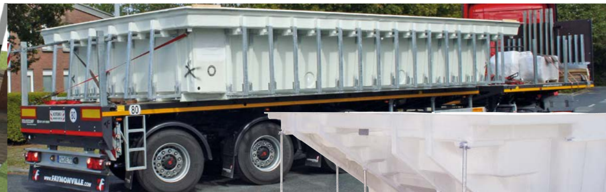
Installation avec supports de parois
