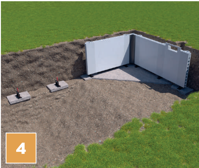
ALIGNEMENT DES STRUCTURES ( Skimmer, projecteur... pré-installé en usine )
