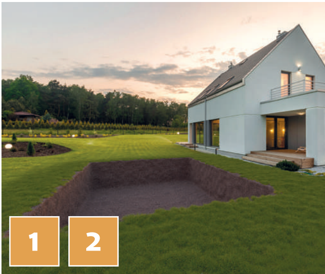
TERRASSEMENT ET CONTRÔLE DES NIVEAUX
