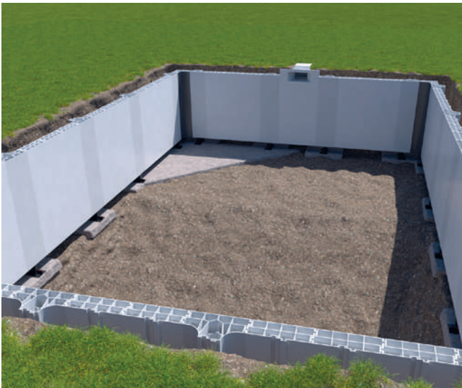
ALIGNEMENT DES STRUCTURES ( Skimmer, projecteur... pré-installé en usine )
